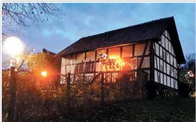
Außenansicht der Kulturscheune während der Dreharbeiten
