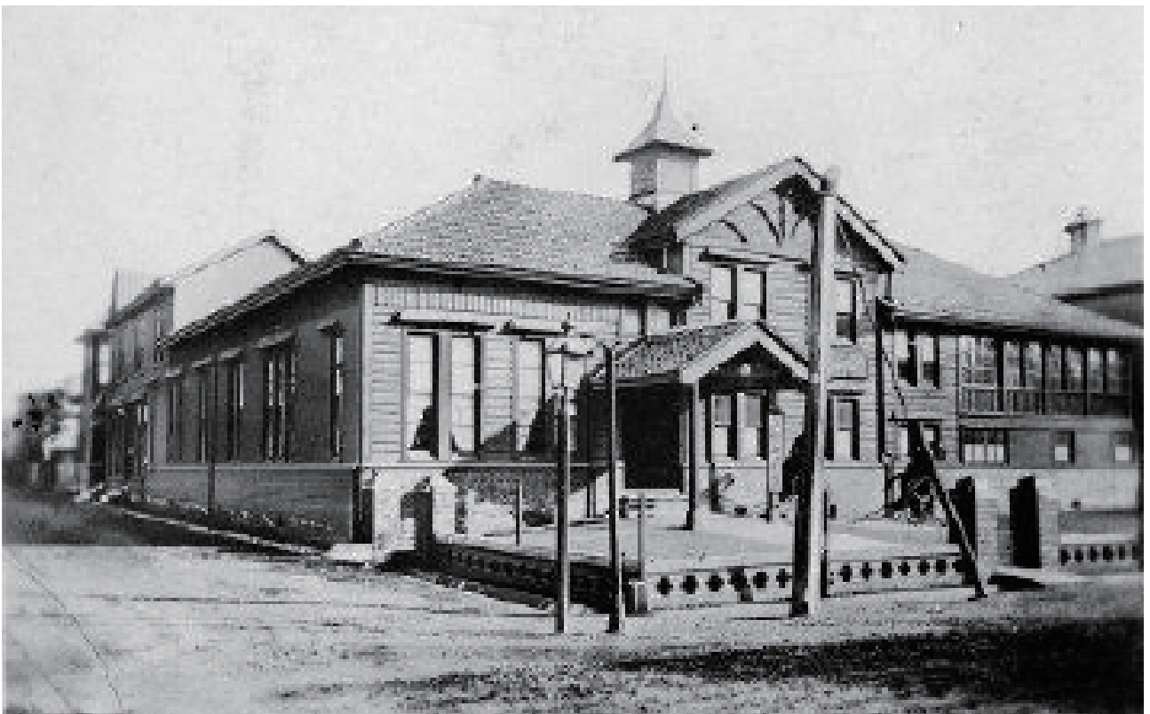
1901年聖路加病院創設時の建物 京橋区明石町37番
