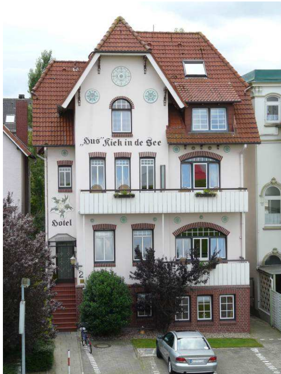
Hus Kiek in de See 609
