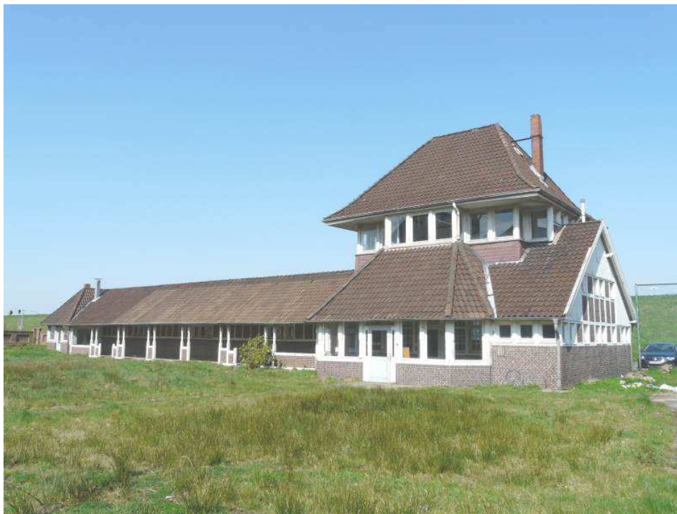
Kegelbahn 619 , vom Stabsgebäude-Innenhof gesehen
