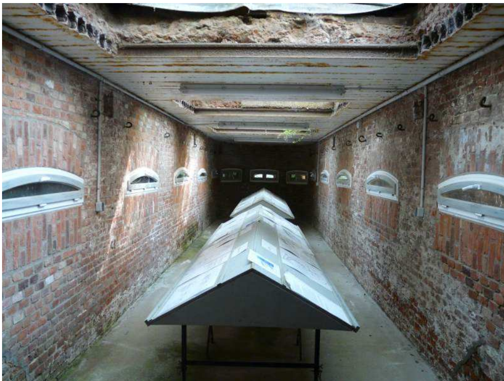
Fort Kugelbake, Grabenabwehr Innenansicht, an den Wänden unterhalb der Decke Wandhaken für das Aufhängen von Hängematten 635
