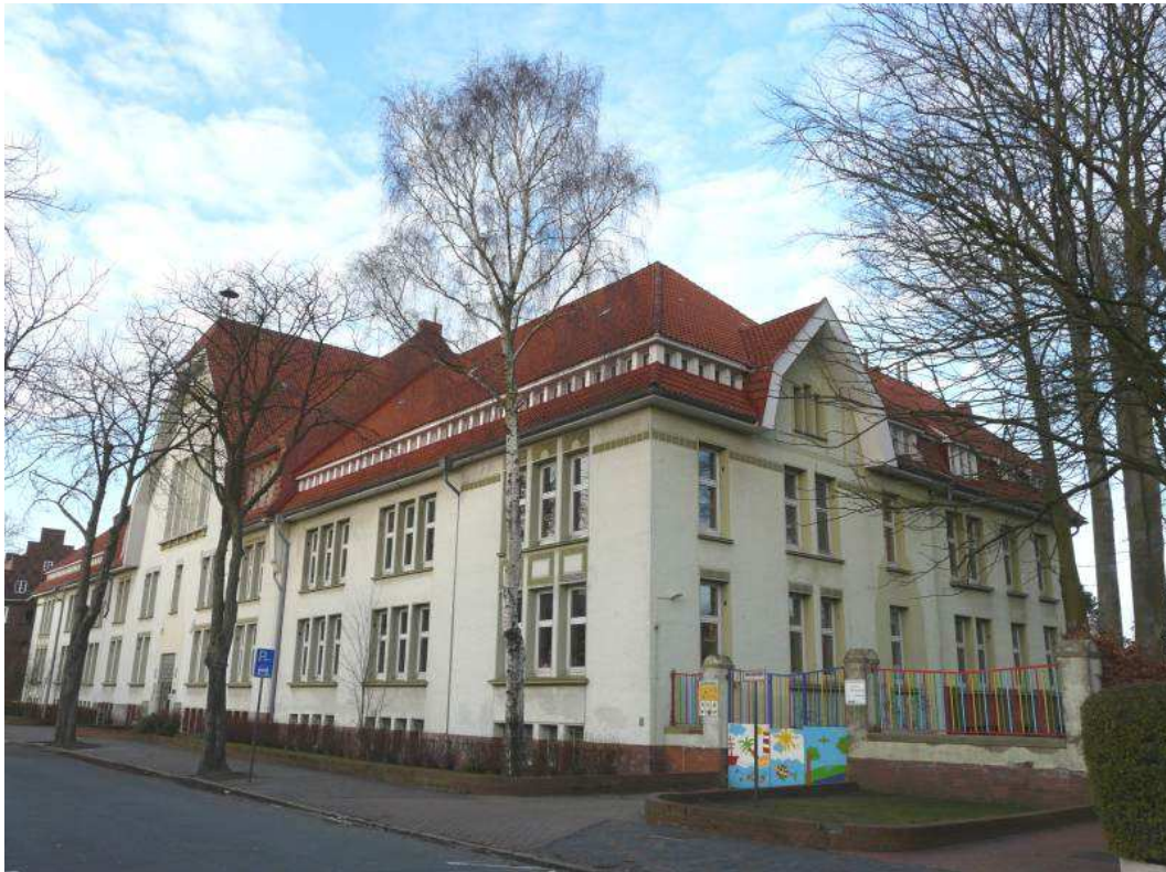
In der Kiautschou-Kaserne 628 befindet sich heute die Gorch-Fock-Schule
