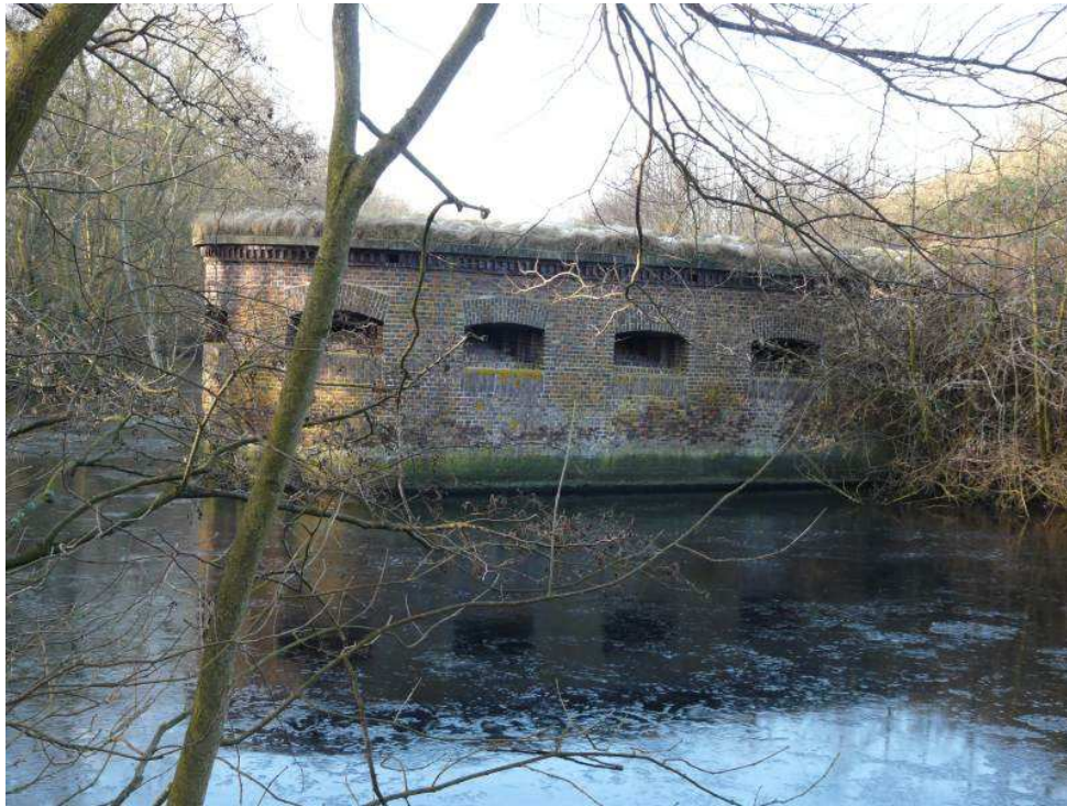
Fort Kugelbake, doppelte Grabenabwehr der Grabenflankierung
