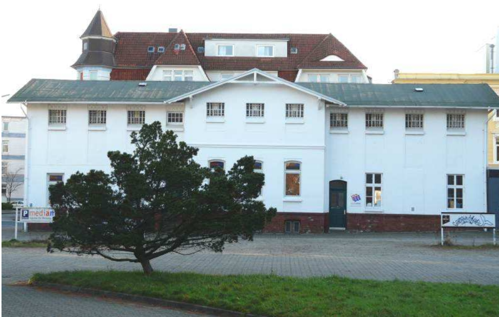
Arrestgebäude 621 vom Exerzierplatz gesehen
