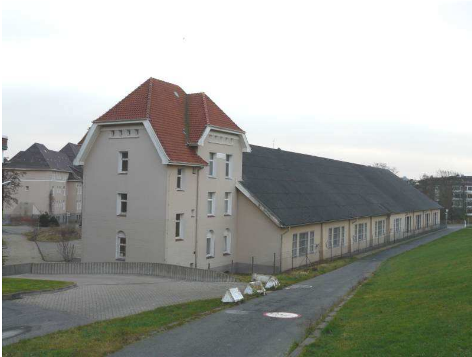
Exerzierhalle 624 vom Deich aus gesehen
