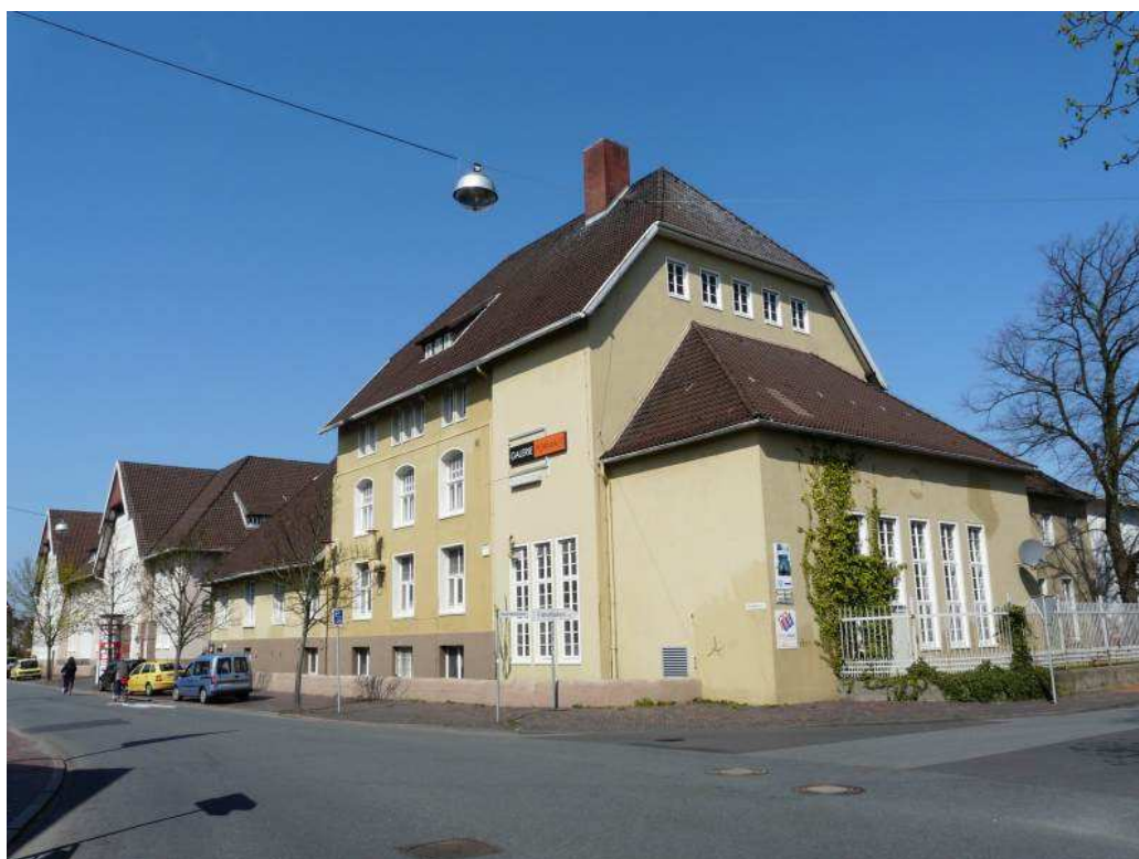
Wirtschaftsgebäude von der Marienstraße gesehen
