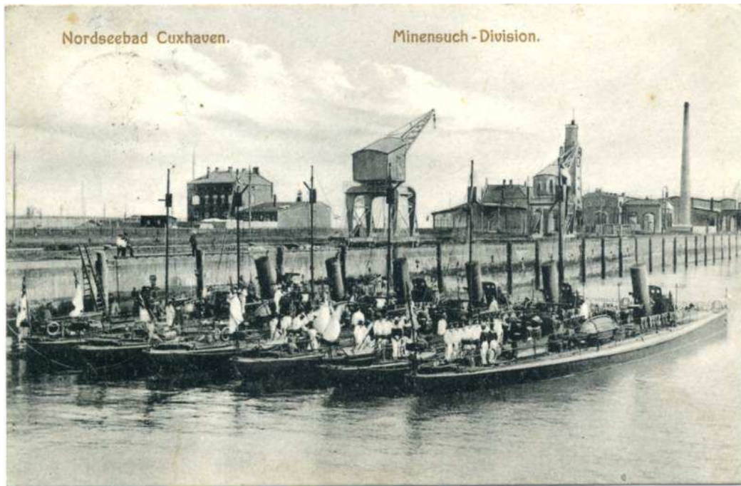
Minensucher 595 im Neuen Hafen / Amerikahafen 596 und Elektrizitätswerk 597
