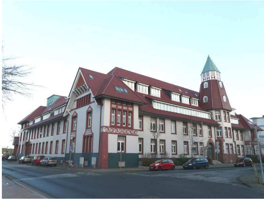
Stabsgebäude und Offizierskasino 616 von der Kasernenstraße gesehen (erbaut 1907/1908)
