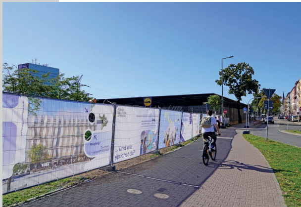
Seit September 2025 ist das Grundstück von einem Bauzaun umgeben. Foto: IDS
