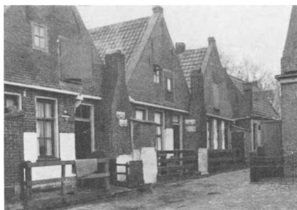
Fig. 55. Wijk III. Forten rechts van de voordeur. (gebouwd omstreeks het einde der vorige eeuw; de geheele voorgevel is van steen).
