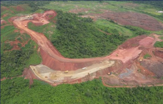
Bacaba: Execução da Pré-remoção (Pre-stripping) e Acessos
