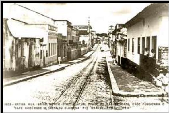
Figura 05: Rua na qual está implantada a Igreja do Rosário. 1903. Sentido Norte/Sul.
