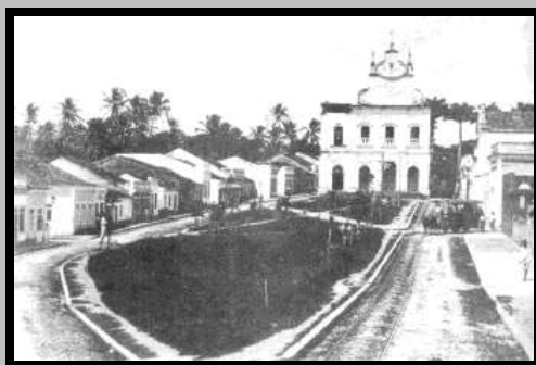
Figura 35: Pátio das Mercês em 1910. Fonte: Acervo fotográfico Walfredo Rodrigues.
