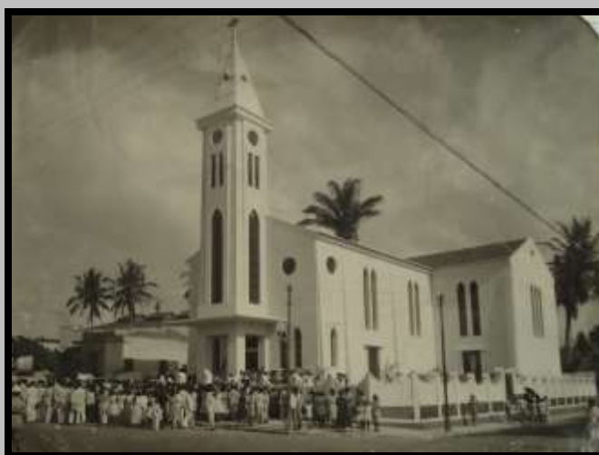
Figura 51: Inauguração da nova Igreja das Mercês, em 01 de Novembro de 1939.
