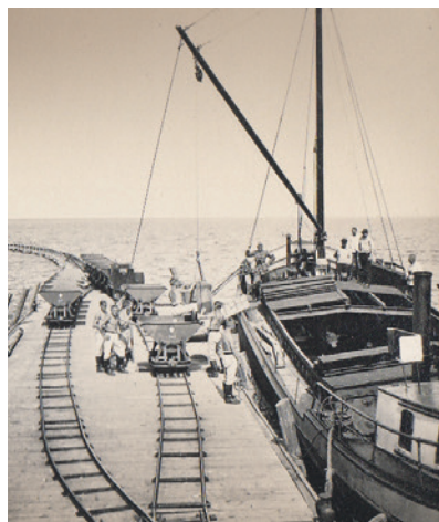
Arbeitsmaterialien werden mit Loren verladen.
