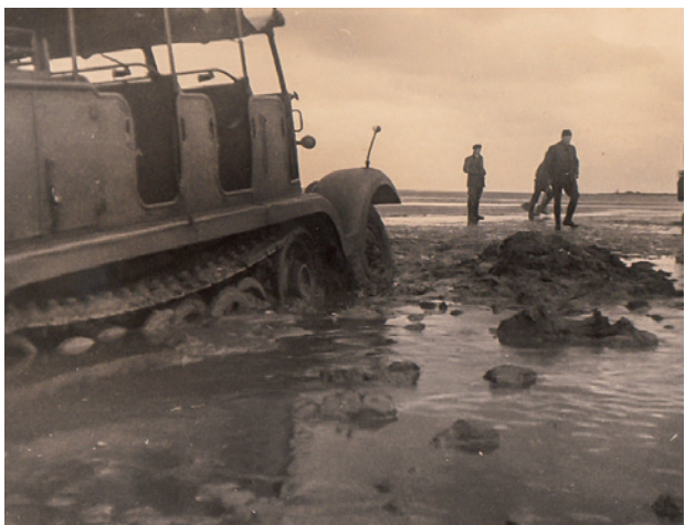
Bei der Anlegung der Lahnung waren die Arbeitsbedingungen schwierig. Ein Kettenfahrzeug ist im Schlick eingesackt.
