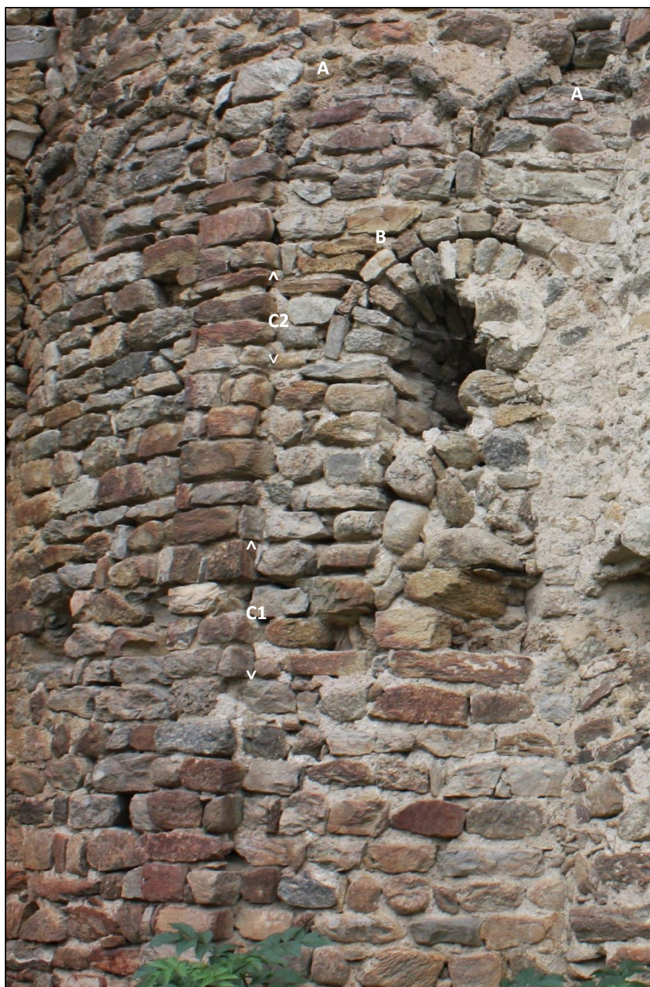
Figure 265: Sainte-Eulalie de Fuilla d'Avall. Principal apse masonry.
