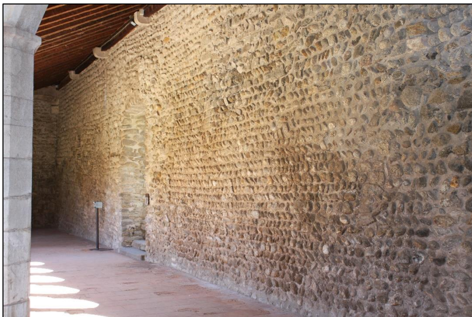
Figure 108: Sainte-Marie d'Arles sur Tech, north wall
