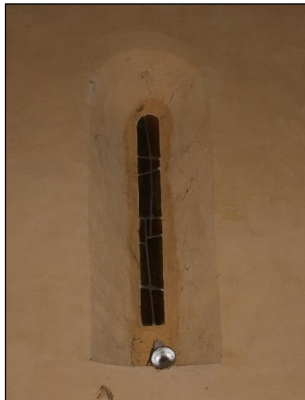
Figure 172: Sainte-Eulalie de Fuilla d'Aval. Interior, nave window (north wall).
