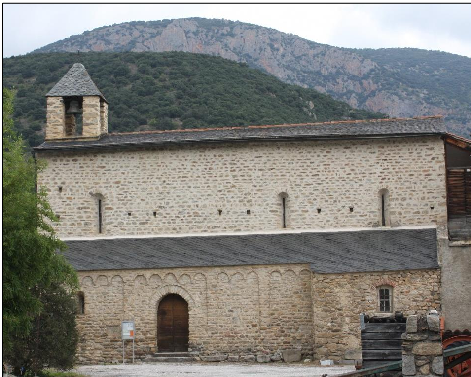
Figure 164: Sainte-Eulalie de Fuilla d'Aval. South elevation.
