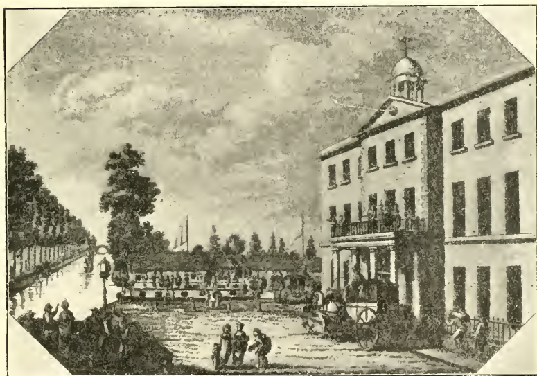
FIG. 2.—GRAND CANAL HOTEL, DUBLIN.
